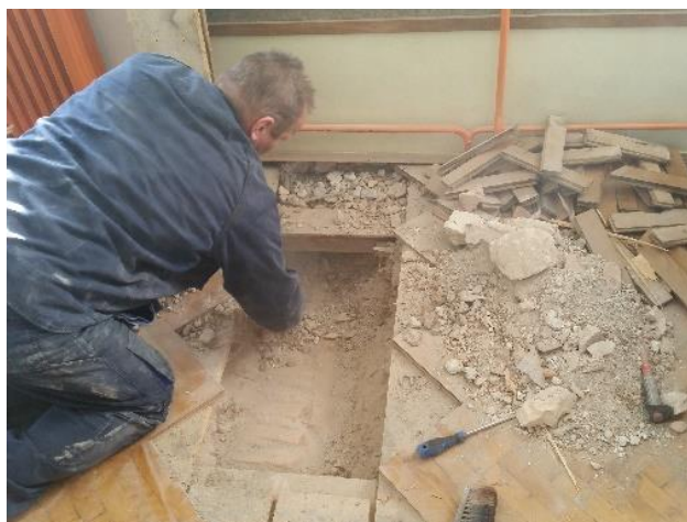
V oktobru 2014 so sondirali stene in tla ter ugotavljali protipotresno stanje objekta.
