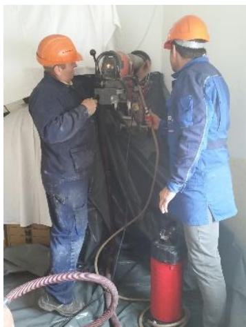
V oktobru 2014 so sondirali stene in tla ter ugotavljali protipotresno stanje objekta.
